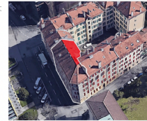
Des panneaux photovoltaïques couvrent le pan de toiture côté cour
