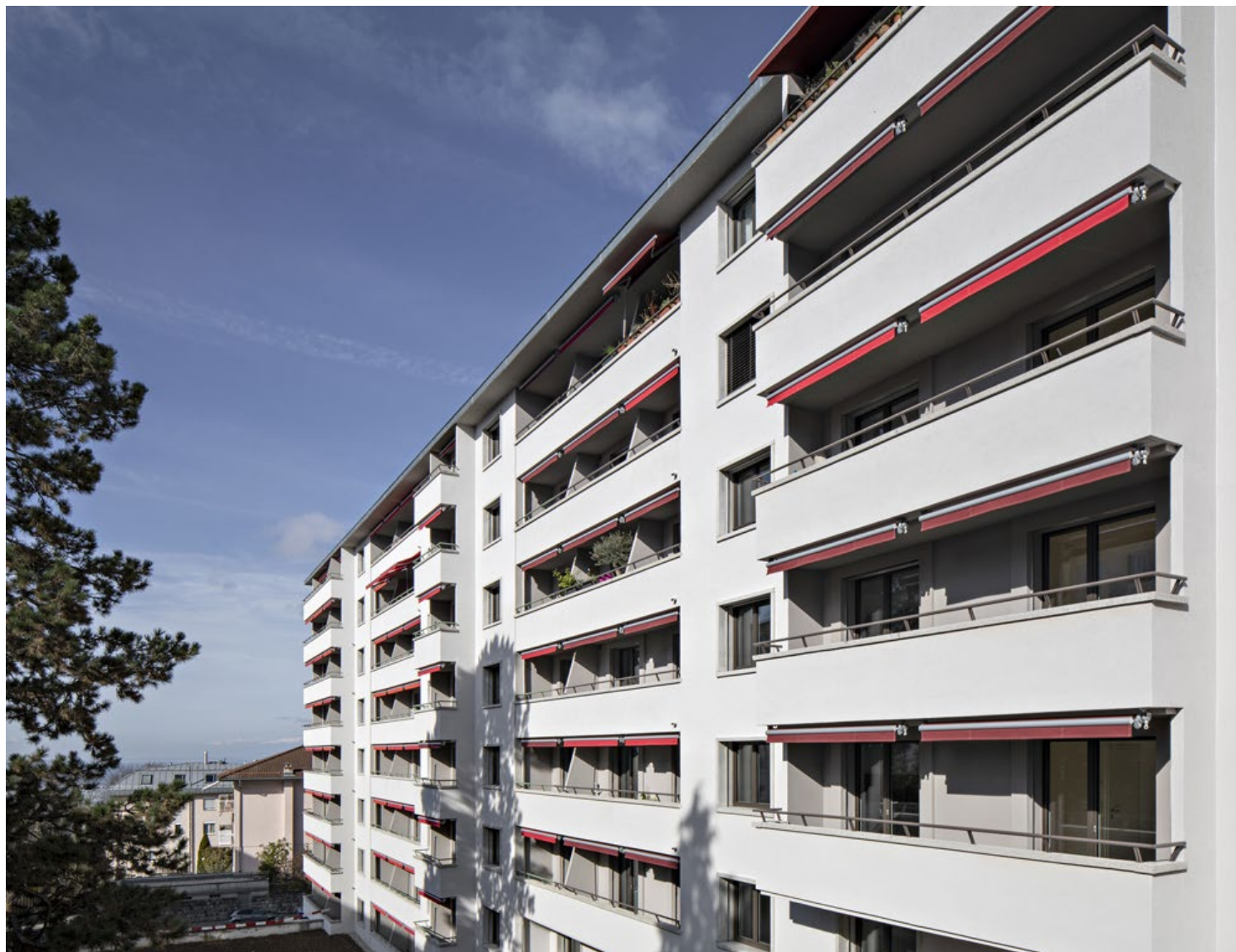
Rénovation immeubles Boisy, Lausanne Architectes: Terrin Barbier architectes, 2021-26 / MO: SCHL
