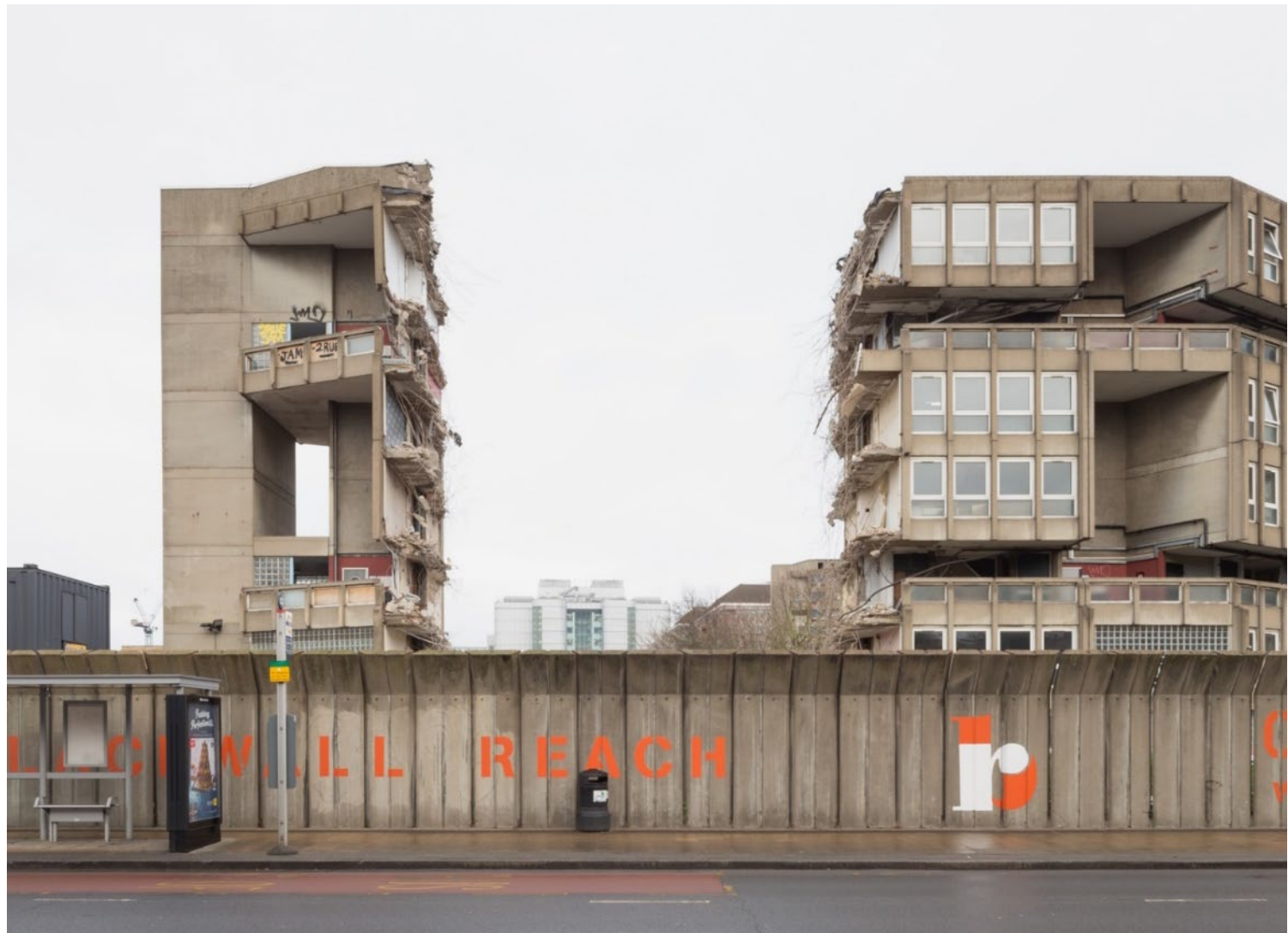
Robin Hood Gardens, Allison & Peter Smithson, 1972. Démolition, 2020 Photo: Francisco Ibanez Hantke, 2019
