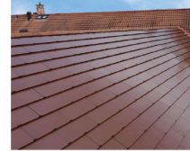
Les panneaux rouges remplacent les tuiles et s'intègrent dans le contexte Référence voir fiche méthodologie
