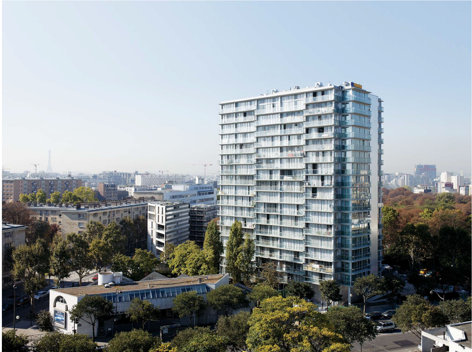
Tour Bois-Le-Prêtre, Paris Immeuble d'origine: Raymond Lopez, 1959 Transformation, Lacaton-Vassal et Druot, 2011 / Photo: David Boureau
