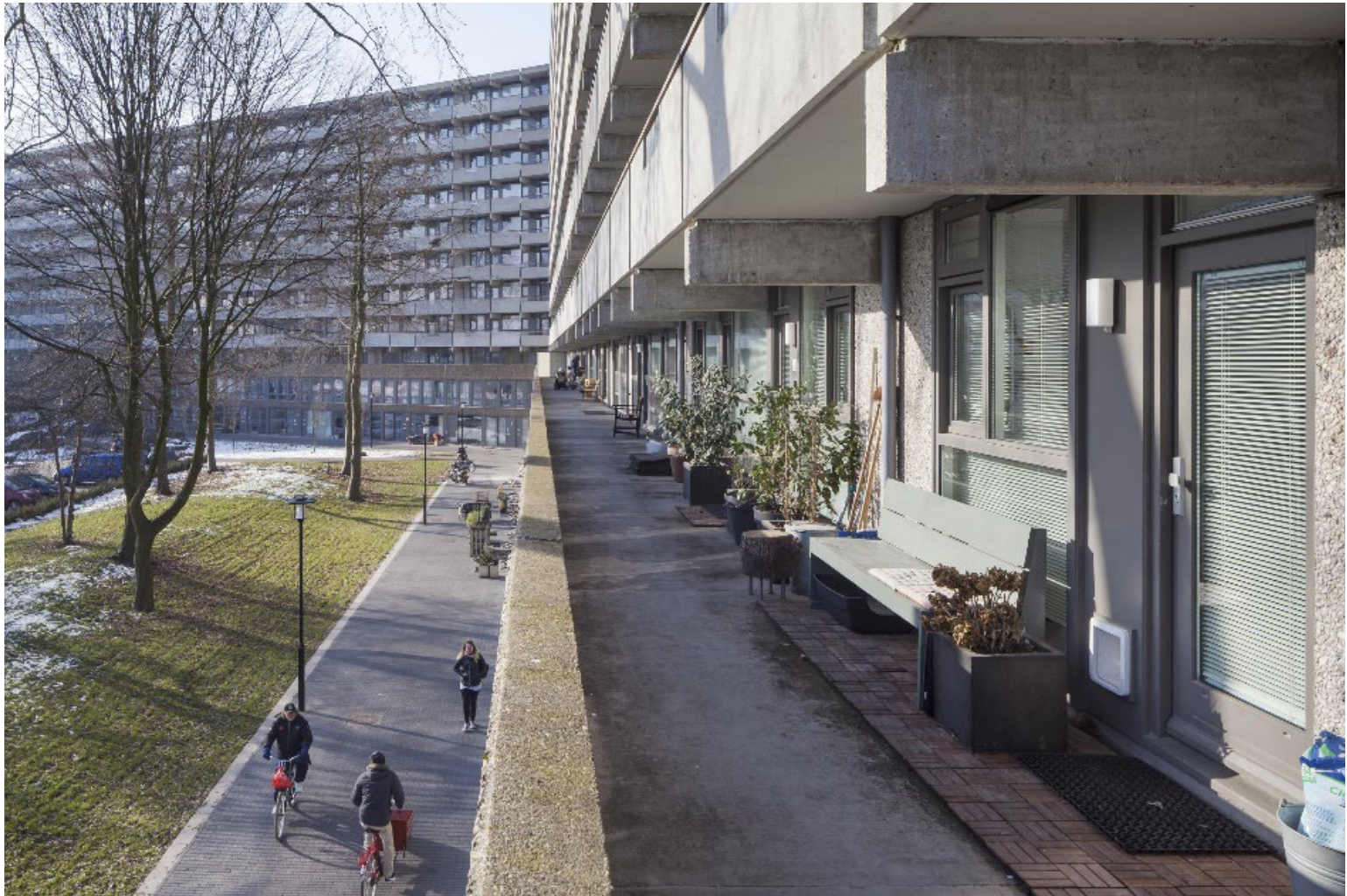
De Flat Keiburg, Amsterdam Bâtiment d'origine: Bijlmermeer. Architecte: Siegfried Nassuth, 1960s Transformation: NL Architects, XVW architektur, 2012-16 Photo: Marcel van der Burg
