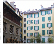
La façade cour plus modeste permettrait une revalorisation avec des balcons
